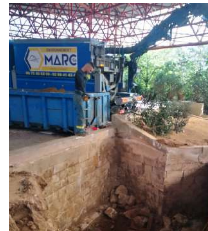
Théâtre urbain en travaux © Le Triangle
