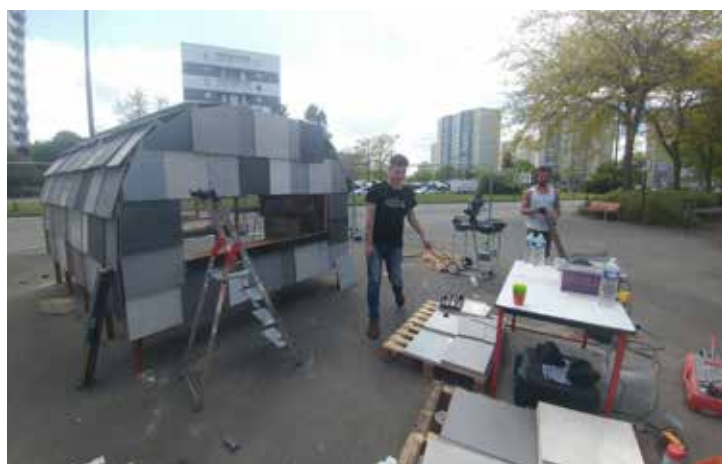
Construction de la Cabane © Justine Saulière
